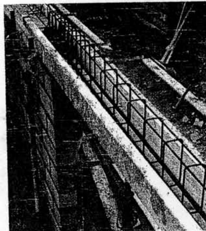
14 Linteau de garage. Coffrage et armature
