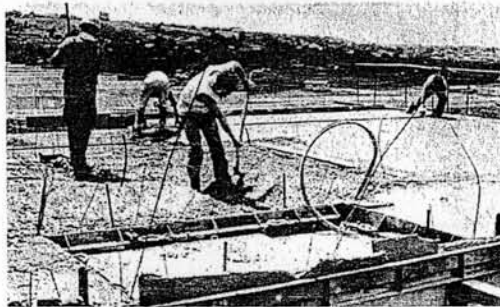
⑲ Coulage du béton
