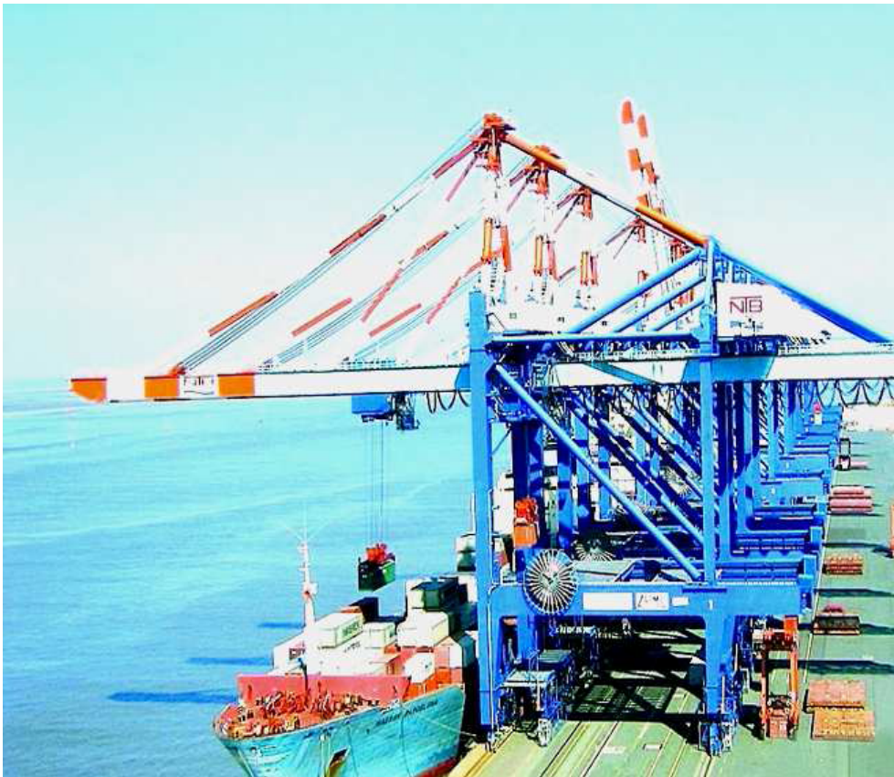
FIGURE 3.1 – Grue portuaire : portique à containers
