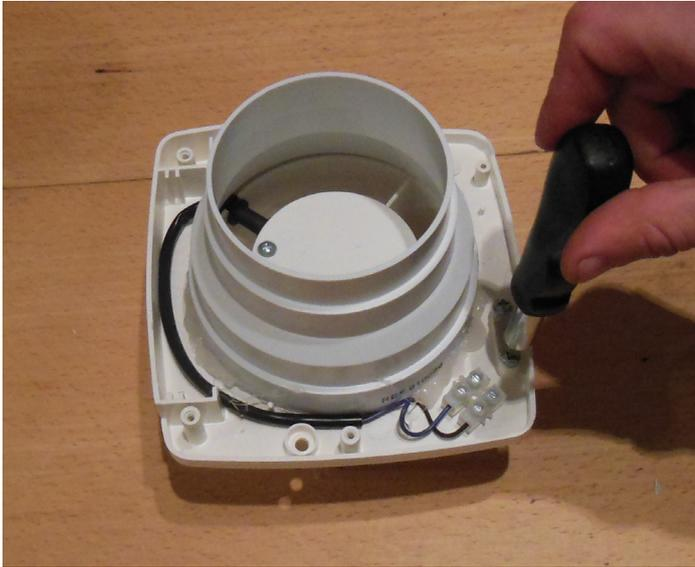
Utilisons à présent notre superbe câble d'alimentation à son dessein sur cet Extracteur. Mettez bien en place le petit bloque cable et vérifiez qu'aucun excédent de cuivre n'est visible. En 220V on ne rigole plus ! J'ai d'ailleurs scellé tout cela à l'aide de mon fidèle pistolet à colle pour éviter tout risque de court-circuit.
