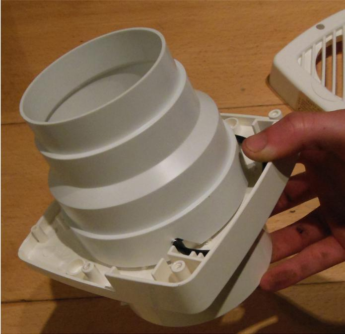
L'adaptation est réussie! Si le résultat est jugé satisfaisant, on s'arme d'un pistolet à colle pour être sûr de réaliser une jonction solide et étanche.
